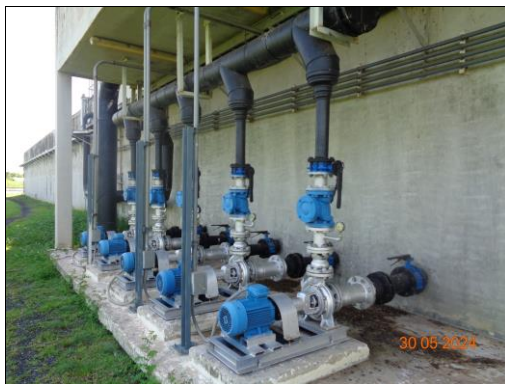
ภาพที่ 2.2-7 อุปกรณ์สำรองที่ใช้ในระบบบำบัดน้ำเสีย
