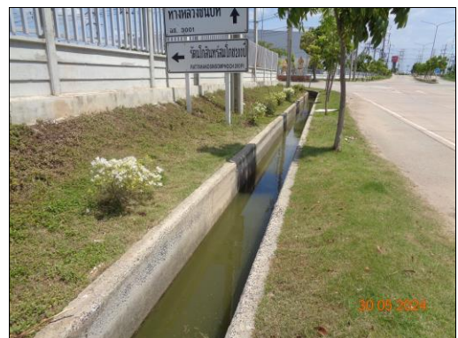
รูปที่ 2.2-4 รางระบายน้ำฝนภายในนิคมฯ
