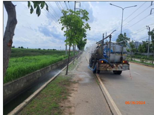
ภาพที่ 2.2-21 การนำน้ำทิ้งหลังผ่านการบำบัดไปใช้รดน้ำต้นไม้ภายในนิคมฯ
